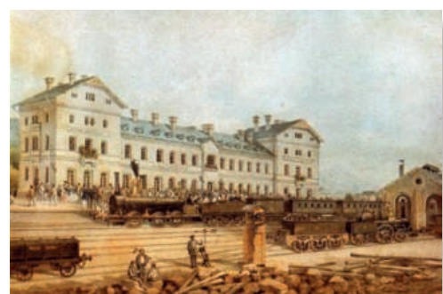
Der Bahnhof Meiningen im Jahr 1859. Meiningen station in 1859.
